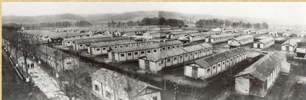
Vue du camp depuis le château d'eau
